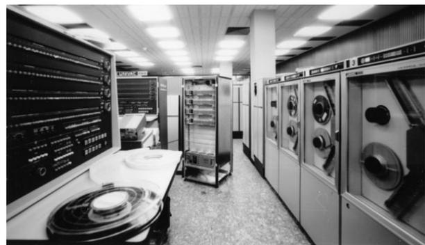
Abb. 14: Links die beiden U418-III, in der Mitte der Inter Computer Coupler vor seiner Installation, rechts Magnetbandgeräte UNISERVO VIC
