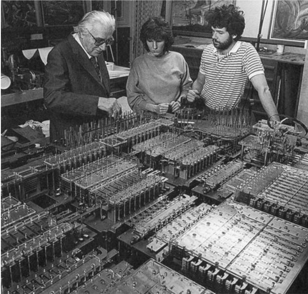
**Abb. 14: Konrad Zuse, Ursula Schweier und Dietmar Saupe an dem fast fertig gestellten Nachbau der Z1<sup>1</sup>**
