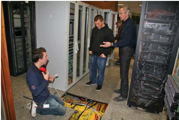
Abb. 4: Arbeiten an der Verkabelung im Unterboden des GWDG-Maschinenraumes unter Anleitung des Ausbilders Herrn Gutsch
